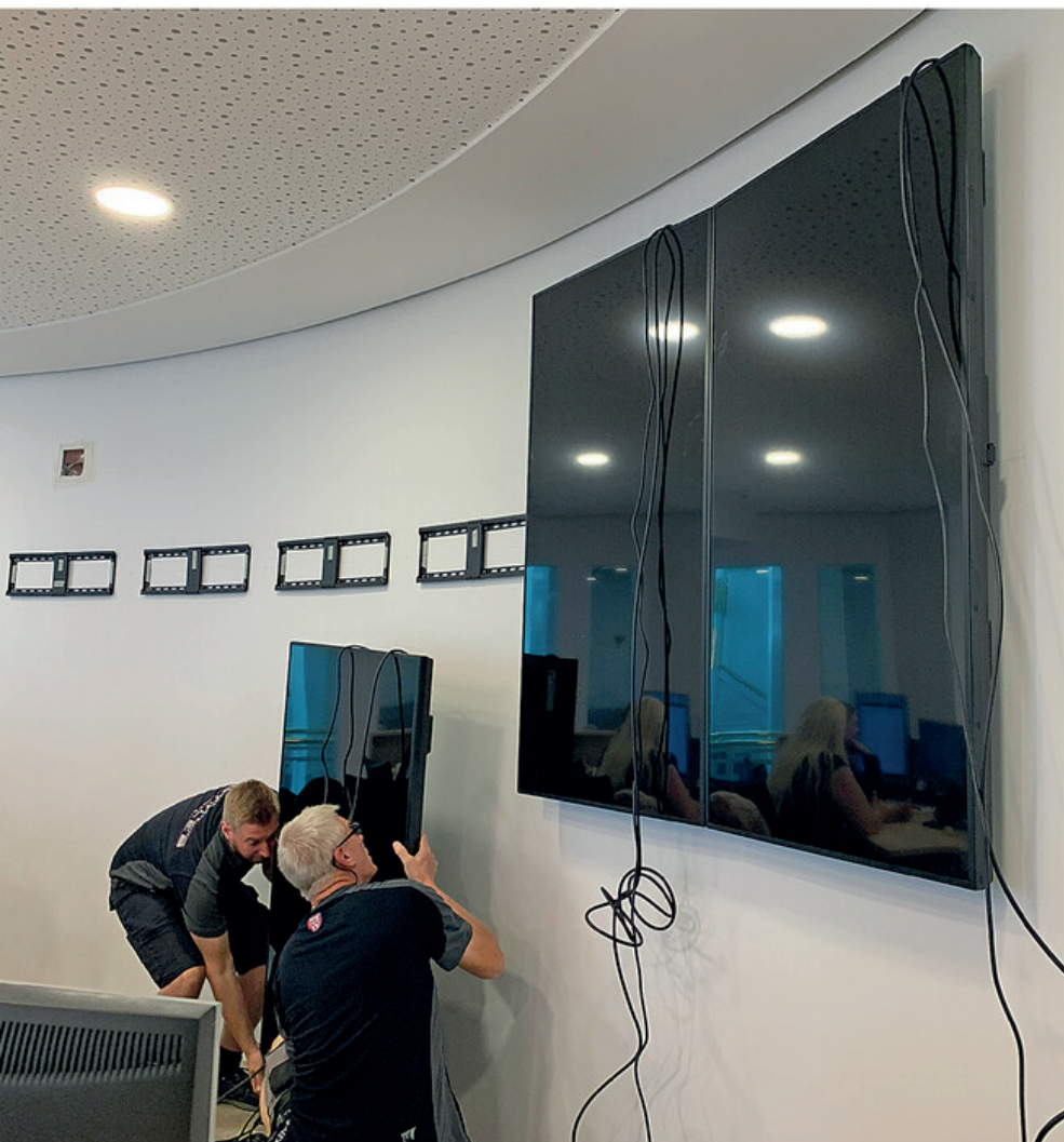
Die gekrümmte Wand war im Rahmen der Installation eine Herausforderung.
